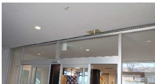
別館風除室天井
