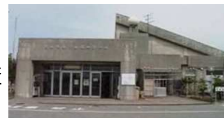
東富山温水プール
