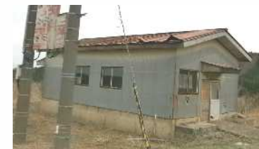
第1ペアリフト沿い倉庫
