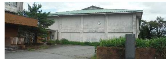
婦中体育館音川分館
