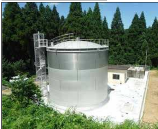
山田低区配水池の耐震化
