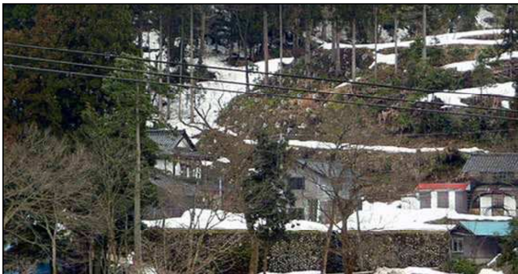
八尾町青根地区(地すべり対策事業)
