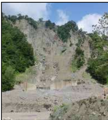
カルデラ内の崩壊状況
