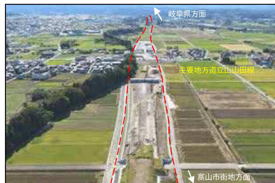
大沢野富山南道路（仮称）福居IC付近施工状況 （令和7年10月 富山市福居地内）
