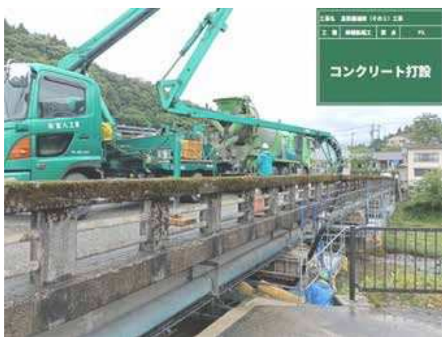
橋梁補修事業（高熊橋） 〔令和7年6月〕
