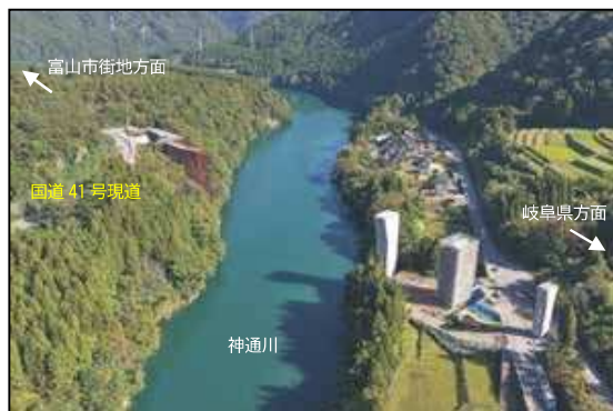
猪谷楡原道路（仮称）片掛橋施工状況 （令和7年10月 富山市片掛地内）
