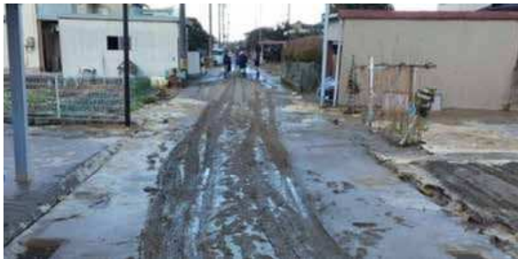
液状化した道路（蓮町五丁目地内）
