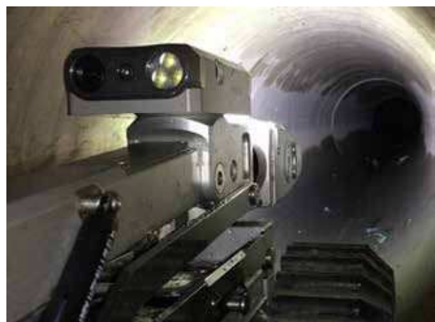
重要管路における自走式カメラによる詳細点検
