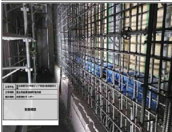
水橋浄化センター管理本館の耐震化
