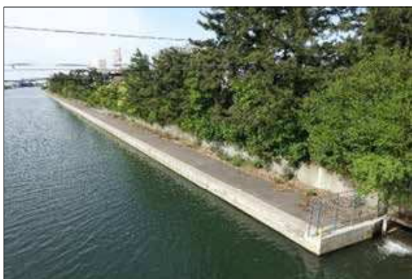
富岩運河（護岸の改修）
