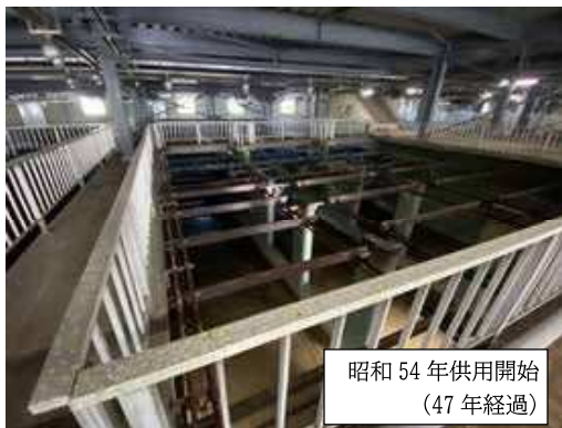
浜黒崎浄化センター内観
