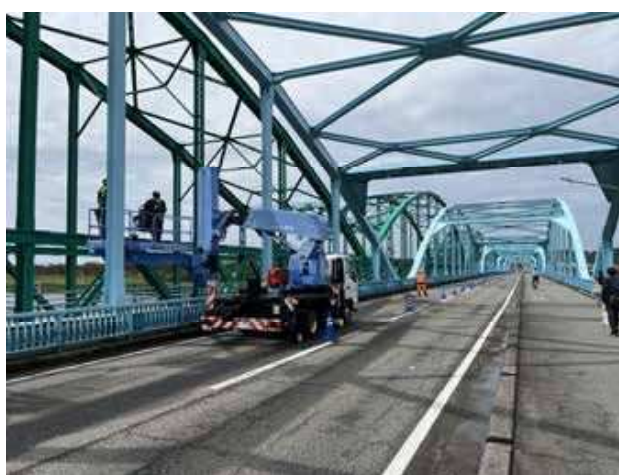
橋梁定期点検事業（神通大橋（下流側）） 〔令和7年9月〕
