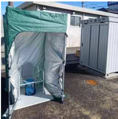
マンホールトイレ (堀川小学校)
