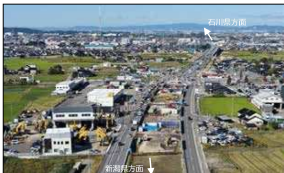
豊田新屋立体 新屋交差点付近施工状況 (令和7年10月 富山市新屋地内)
