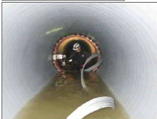
庁星幹線(Φ1400mm)の耐震化
