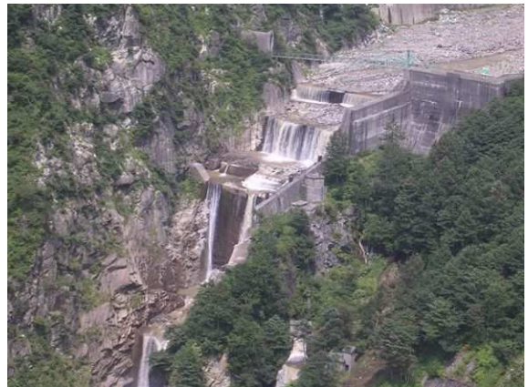
白岩堰堤（常願寺川砂防施設） （写真提供：国土交通省北陸地方整備局 立山砂防事務所）
