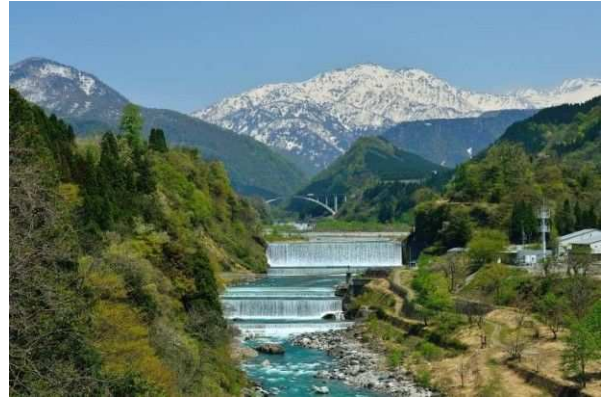
本宮堰堤（常願寺川砂防施設） （写真提供：国土交通省北陸地方整備局 立山砂防事務所）
