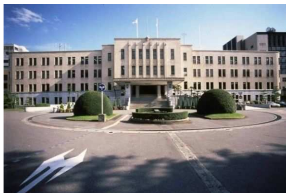
富山県庁舎本館 （写真提供：富山県教育委員会）
