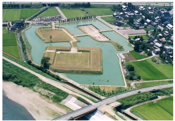
復元された安田城跡
