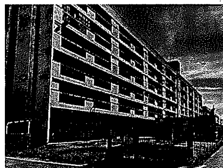
▲解体予定の奥田ビル
