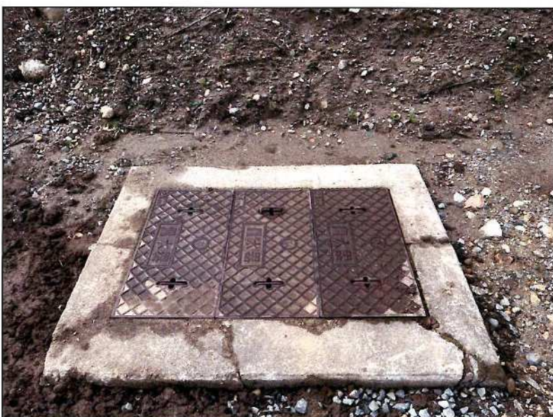
旧八尾中学校 閲覧資料7 23 水道メーターBOX及び、本管 分岐配管 残置 ※メーターは水道局返却 ③水道メーターBOX・給水管残置 (売却地内へ移設)
