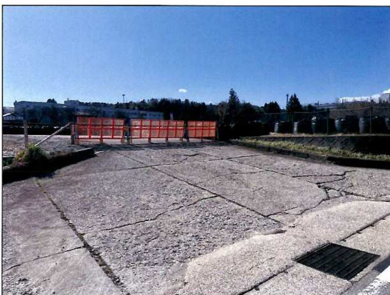
旧八尾中学校 閲覧資料7 1 スロープコンクリート、土間 残置
