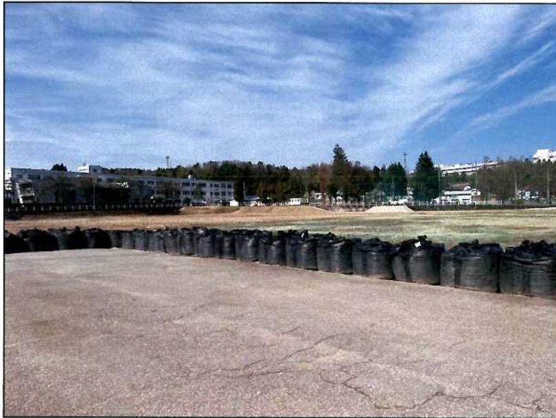
旧八尾中学校 閲覧資料7 22 土砂流出防止対策 トンパック設置
