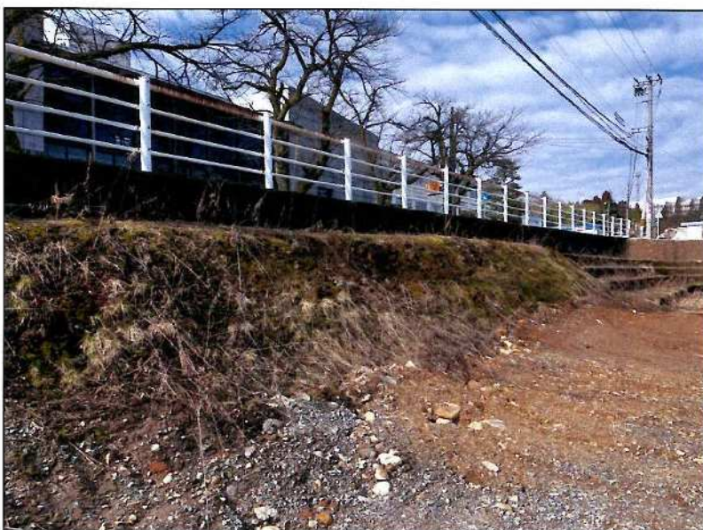
旧八尾中学校 閲覧資料7 6 土の法面 残置 樹木 撤去・抜根
