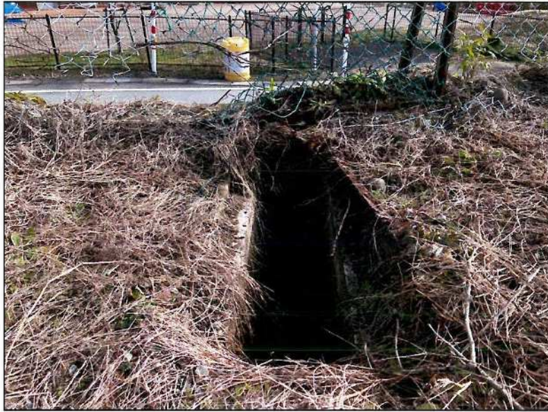
旧八尾中学校 閲覧資料7 2 擁壁、フェンス、擁壁の排水 溝 残置
