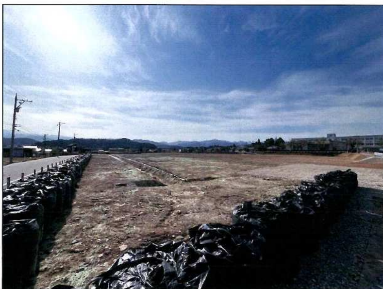
旧八尾中学校 閲覧資料7 敷地全景
