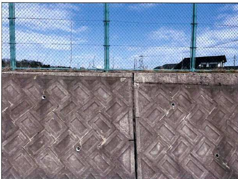
旧八尾中学校 閲覧資料7 18 グラウンドに埋設された透水管 残置
