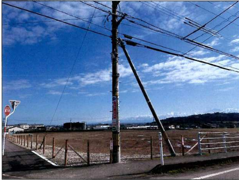
旧八尾中学校 閲覧資料7 25 電柱 残置
