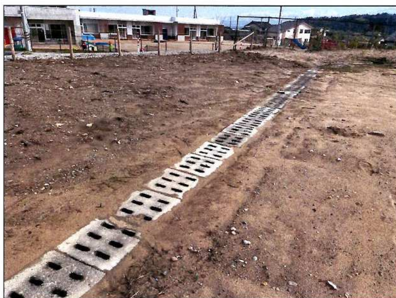
旧八尾中学校 閲覧資料7 15 グラウンド排水のU字溝、排 水樹 残置
