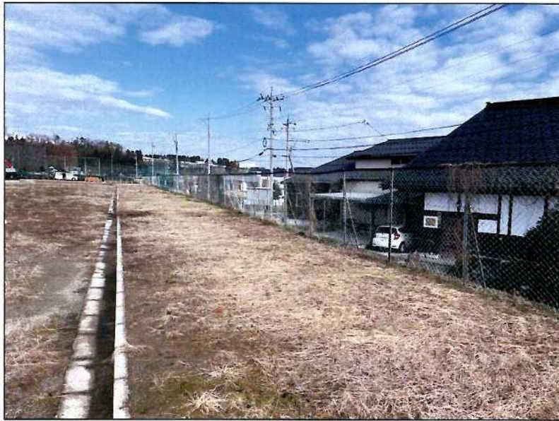
旧八尾中学校 閲覧資料7 16 フェンス 残置 敷地内樹木 撤去・抜根
