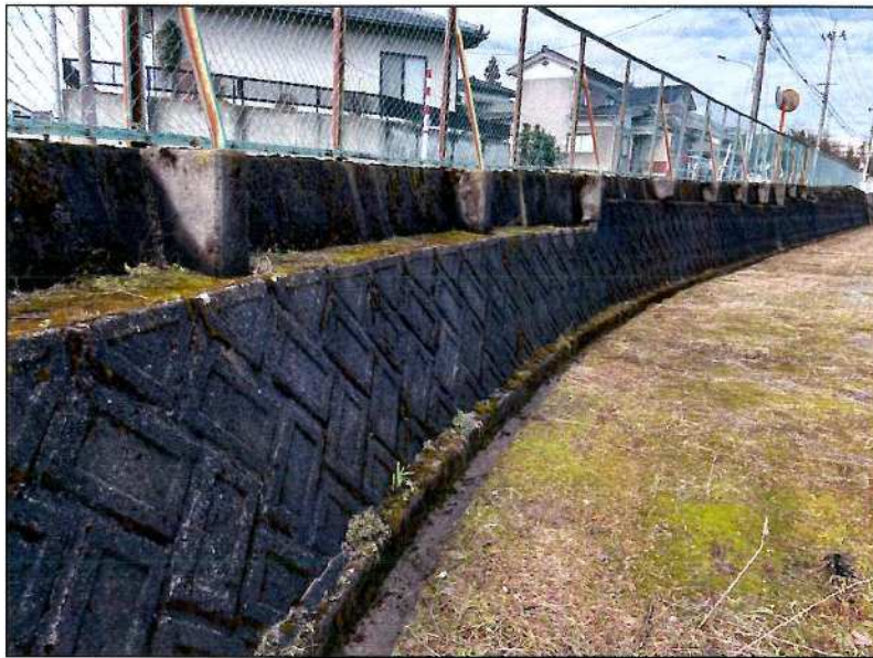
旧八尾中学校 閲覧資料7 19 道路擁壁下側溝 残置 ⑱側溝撤去後土間コンクリート
