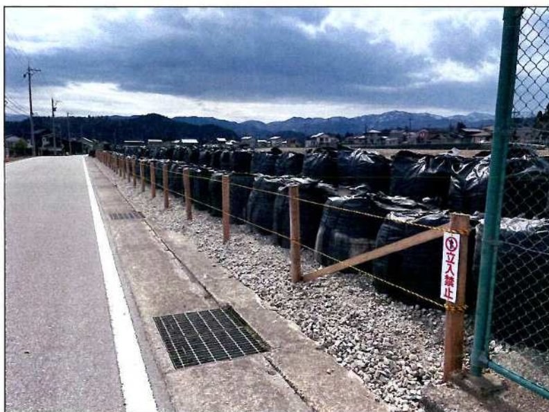
旧八尾中学校 閲覧資料7 13 土砂流出防止対策 トンパック設置
