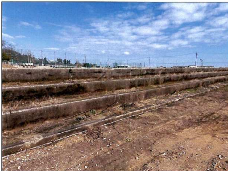
旧八尾中学校 閲覧資料7 20 グラウンド階段状コンクリート 残置
