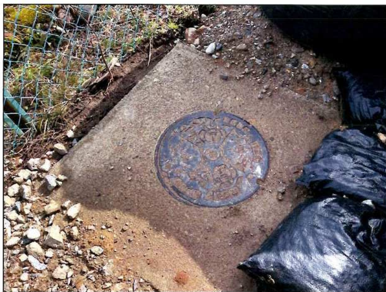
旧八尾中学校 閲覧資料7 24 公共樹 残置
