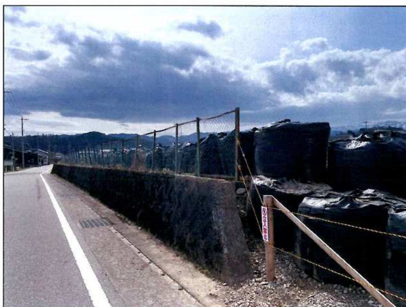
旧八尾中学校 閲覧資料7 13 擁壁、フェンス 残置
