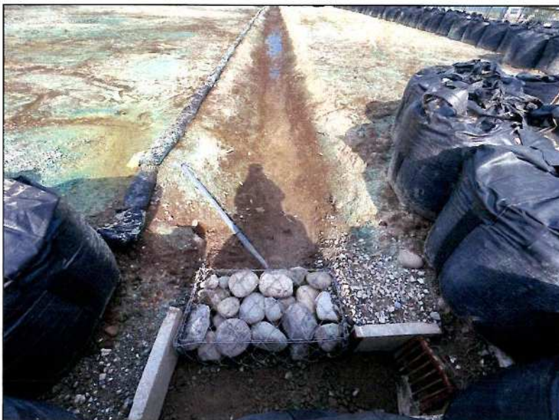
旧八尾中学校 閲覧資料7 22 土砂流出防止対策 素掘り側溝 じゃかご設置
