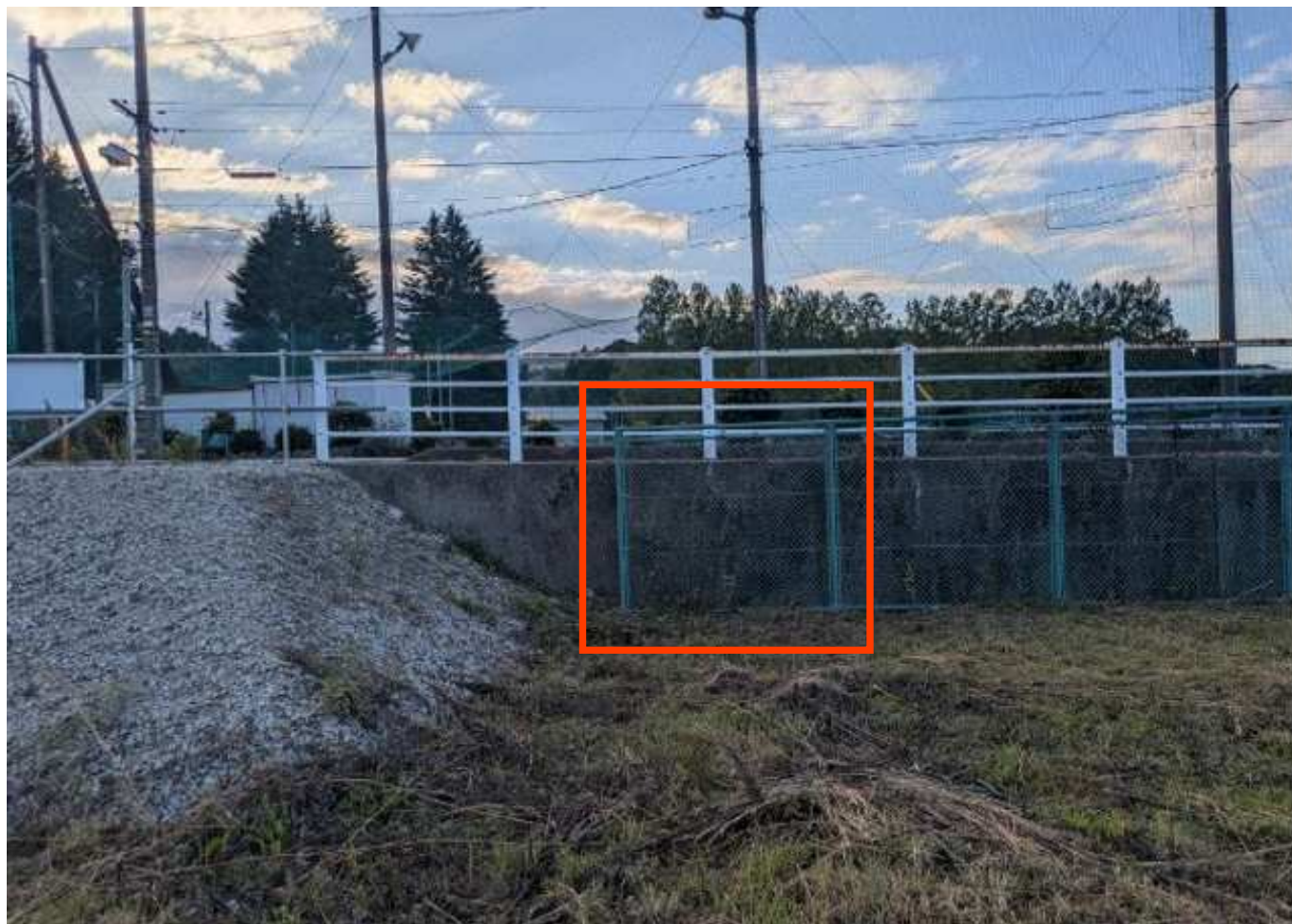
⑪フェンス撤去(令和8年10月撮影)※工事の支障になるため、南端から2m(1スパン)撤去
