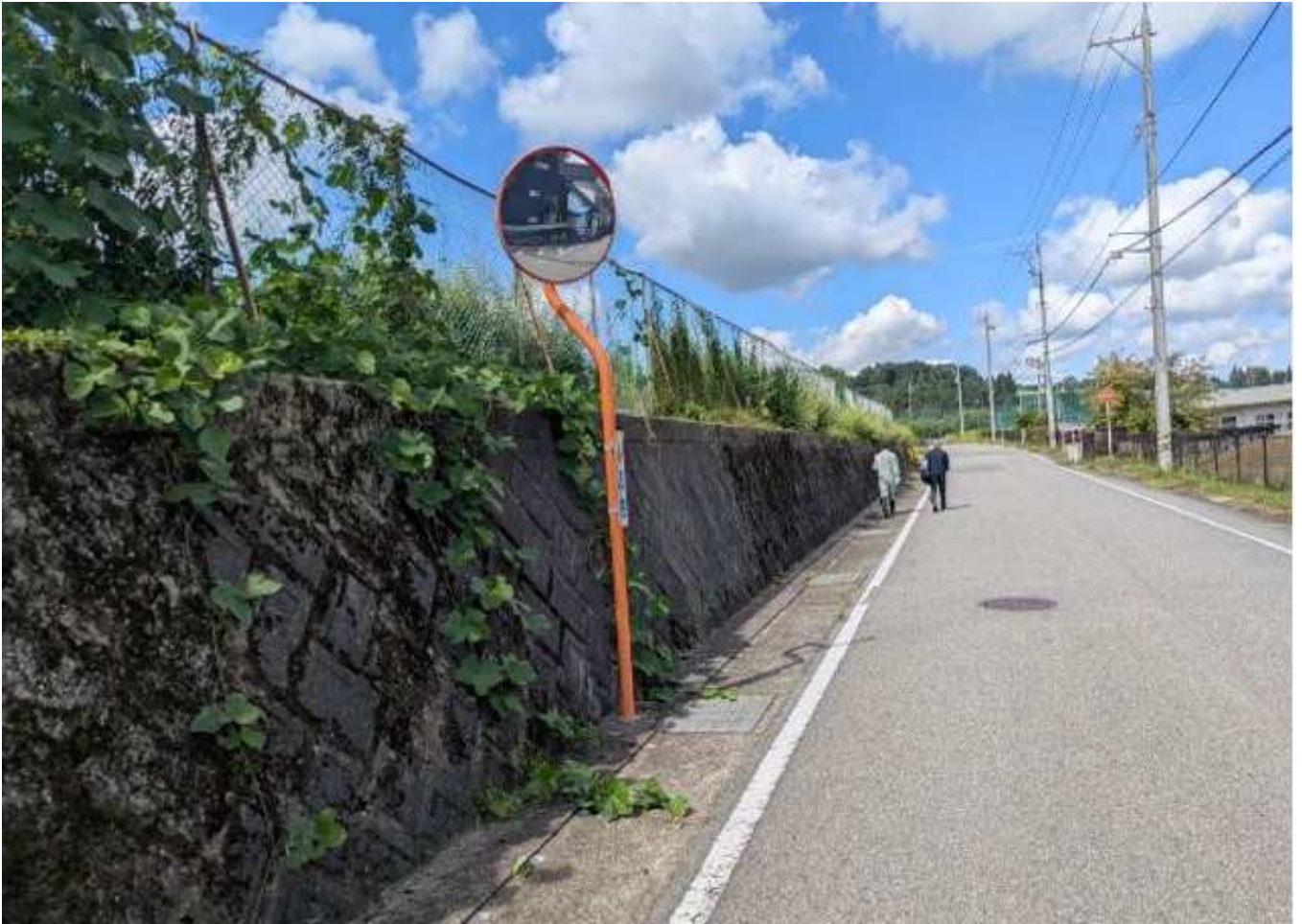
㊴カーブミラー移設(令和8年9月撮影)※写真は市道と売却地に跨っているが、市道内に移設
