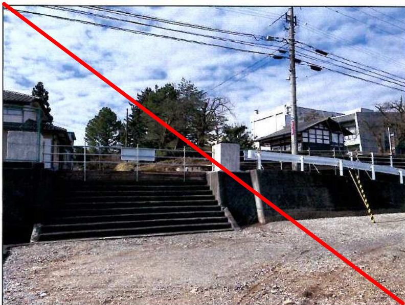
旧八尾中学校 閲覧資料7 5 階段、スロープ、門柱 残置 ⑤工事にて撤去
