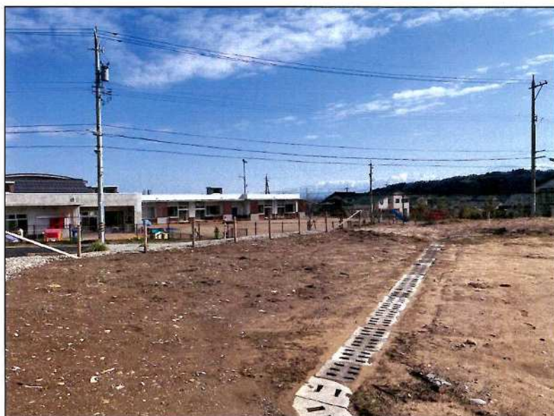
旧八尾中学校 閲覧資料7 14 バックネット裏階段状コンク リート 撤去
